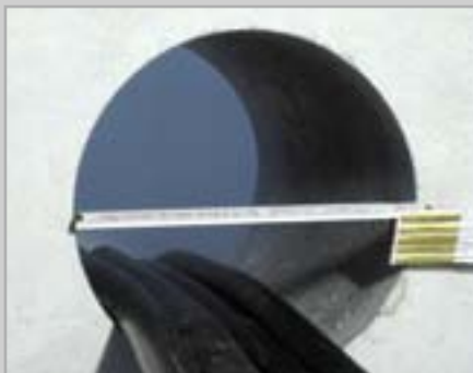
Ausgangssituation Verlegte Kabel
