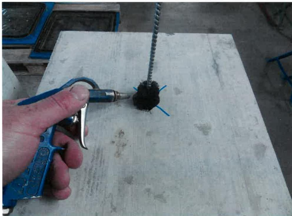
Bild 4 Säubern der Bohrlochwandung
