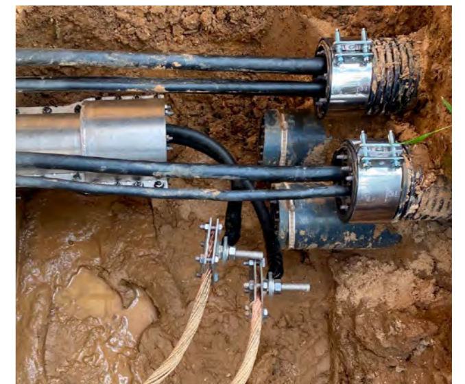
GPD-CV93/G/60/WE50/V2A/EPDM/ (Z)x(D): für die Abdichtung von freiliegenden Wellrohren
