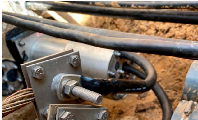
Sonderkonstruktion einer Gebäude-Erdung für Übertragungsnetzbetreiber
