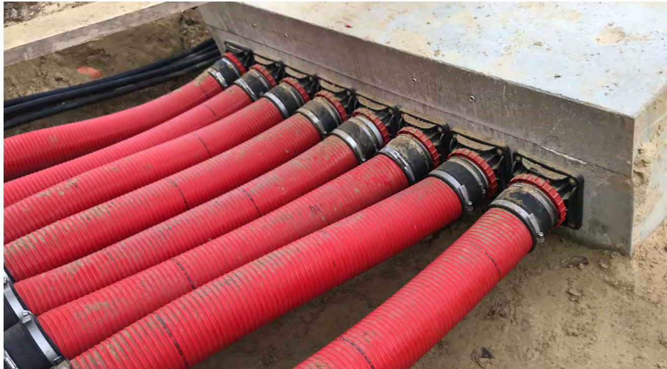
KSS150 mit Anschlusssystem BKD150-D-MA
