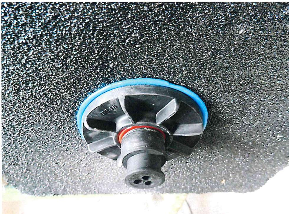
Bild 10 fertig eingebaute *SPE-Einführung*
